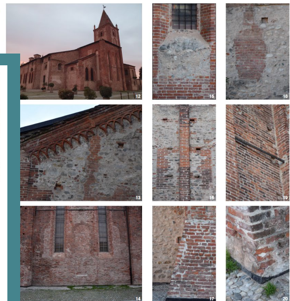
Fig. 11: Differenza tecnica e materiale delle fasi costruttive (foto degli autori, novembre 2022)
