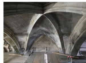
Fig. 10: Volta ad ombrello ribassata della prima campata (foto degli autori, novembre 2022)
