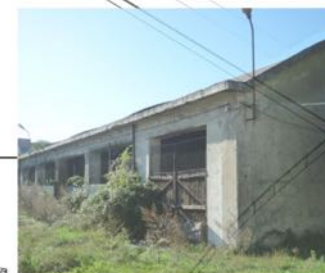
Capannoni costruiti tra il 1935 e il 1954 dal Genio Militare.
