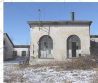
Locale motori-caldia 1913, Ing. A. Tioli. Successivi ampliamenti.
